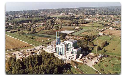
Il nuovo impianto
