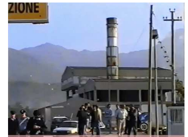
Il vecchio impianto
